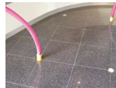
Estrichtrocknung
